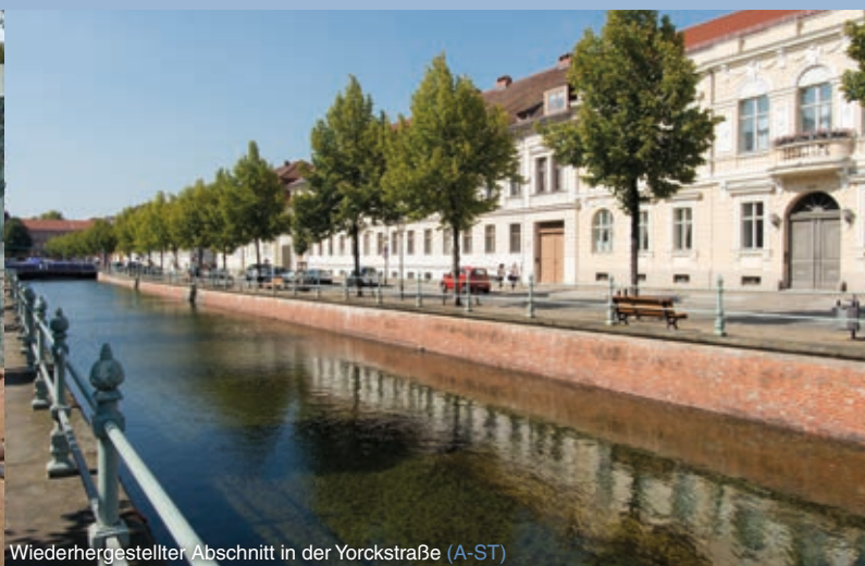
Wiederhergestellter Abschnitt in der Yorckstraße (A-ST)
