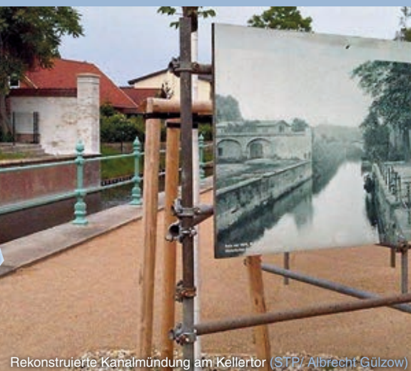
Rekonstruierte Kanalmündung am Kellertor (STP/Albrecht/Gülzow)
